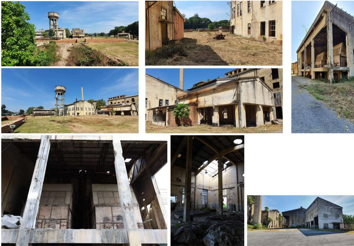
ภาพที่ 31 กลุ่มอาคารเครื่องจักรที่เกี่ยวกับระบบน้ำ การผลิตไอน้ำและกระแสไฟฟ้า
